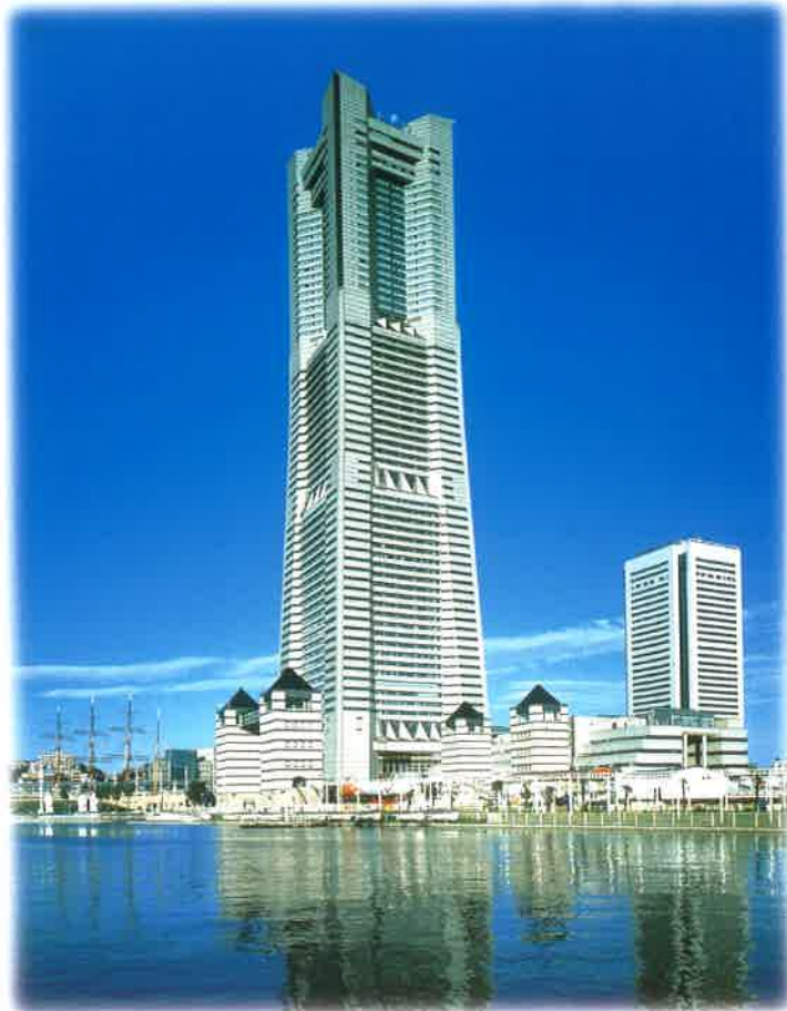
弊社製品は横浜ランドマークタワーの空調管理に使用されています。
